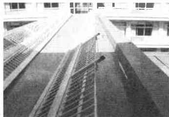
B棟 棟間通路
